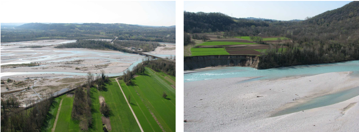
Figura 2 – Le potenti erosioni spondali presenti in sinistra alveo immediatamente a valle del ponte di Cornino
